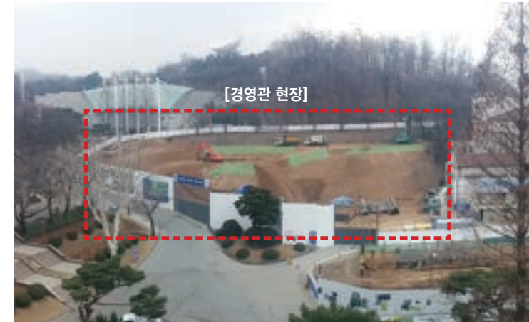
한창 공사 진행 중인 경영관 신축 현장
